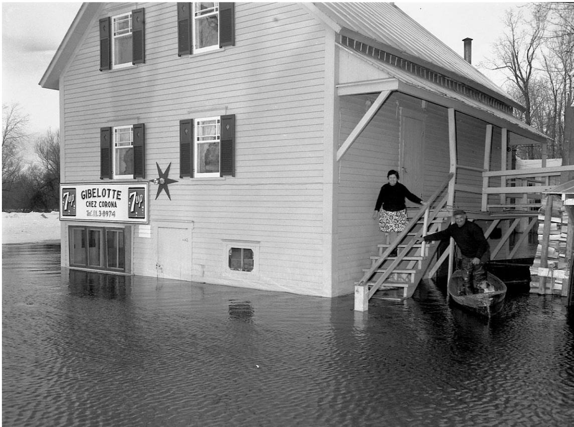
Figure 22: Il est pratique courante d'accoster la chaloupe à la maison en période de crue. Cette maison de l'île d'Embarras comporte les techniques d'adaptation décrites précédemment, soit un escalier extérieur, un rez-de-chaussée surélevé et une passerelle reliant le bâtiment principal à ses dépendances.
